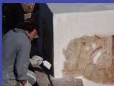
Page 5 Le comptoir en cours de restauration ©Site Olbia, 2012
