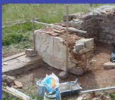
Page 5 Le comptoir en cours de restauration ©Site Olbia, 2012
