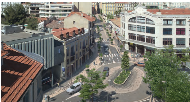
Embellissement du centre-ville, phase 2.
