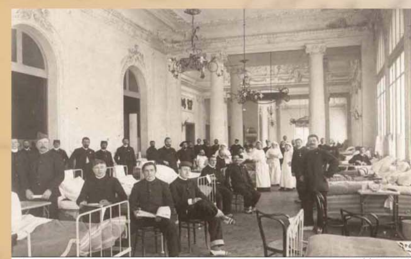
Intérieur du HB N°154 bis (Hôpital du Casino).
