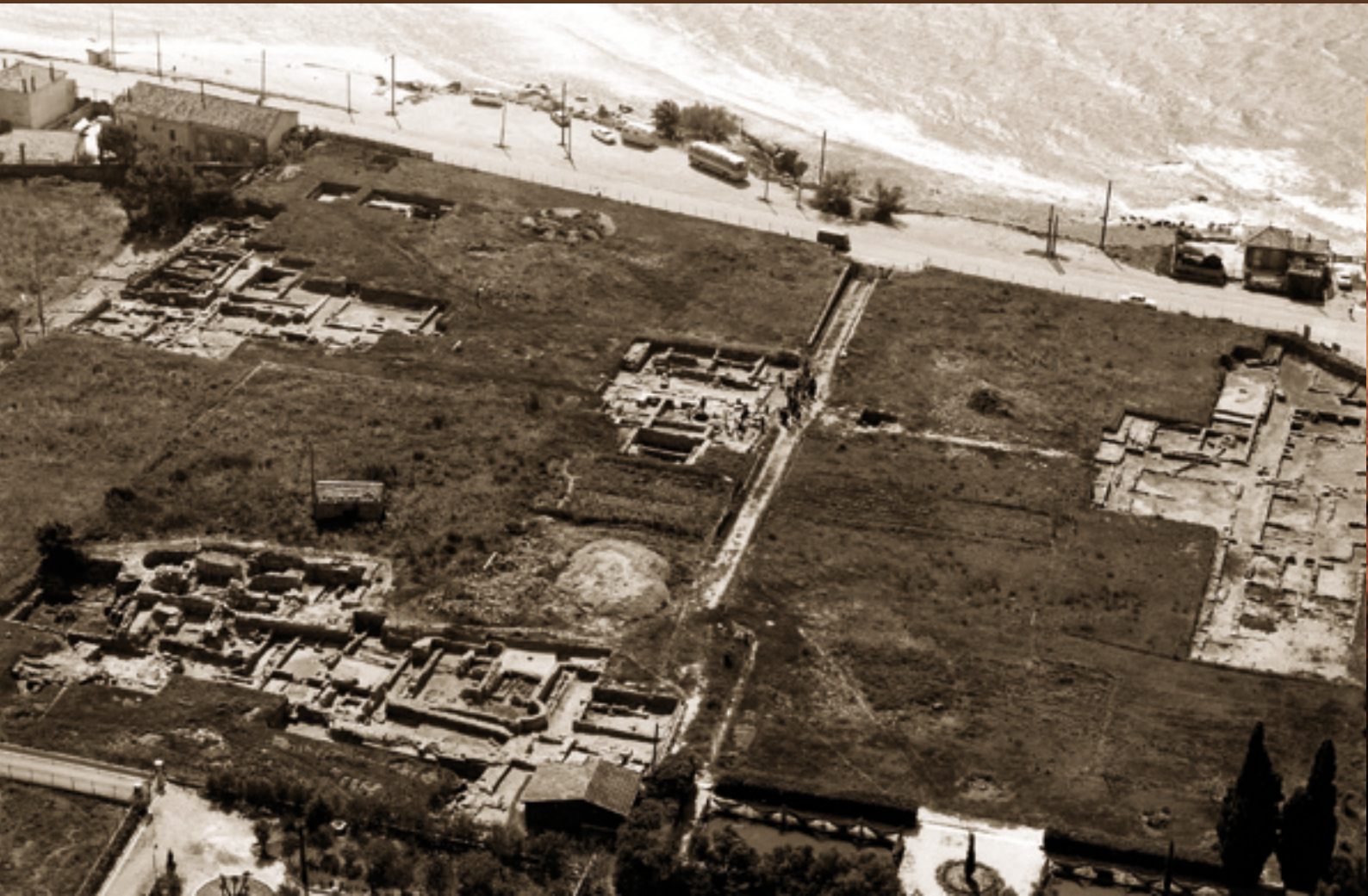
Vue aérienne du site en 1970, archives Coupry.
