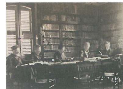
Vue intérieure de la bibliothèque, château Denis, 25 novembre 1890
